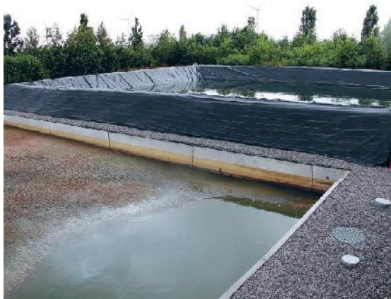
Het slib slaat De Kubbe op in het voorste bassin. In het achterste het water.
