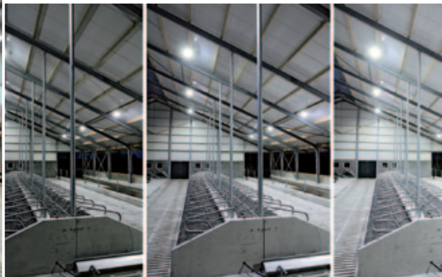
Ledlampen zijn te dimmen. Links zijn de lampen tot 30 watt teruggebracht, in het midden tot 80 watt en rechts branden de lampen voluit op 150 watt.
