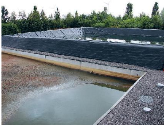
Het slib slaat De Kubbe op in het voorste bassin. In het achterste het water.
