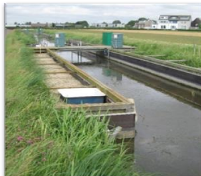
Figuur 2: IJzerzandfilter langs oever.
